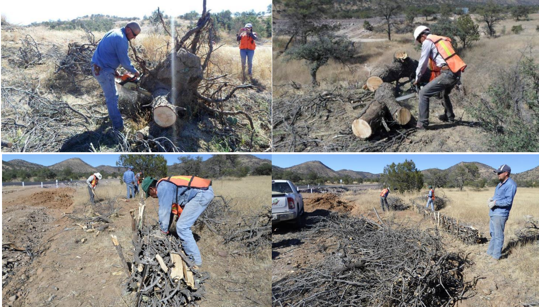
Figura VI.11 Ejemplo del producto del despalme y troceo de material vegetal
