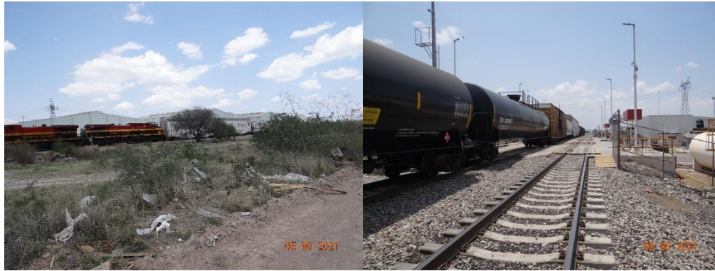
Figura II.2 Paso superior de ferrocarril eje 122
