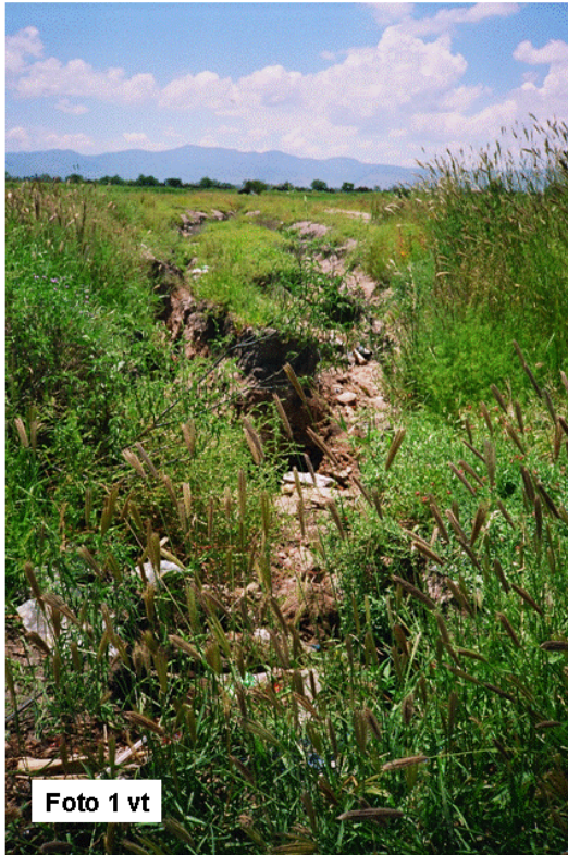
Grieta a la entrada de Villa de Reyes, SLP, que afecta la carretera a Jaral.
