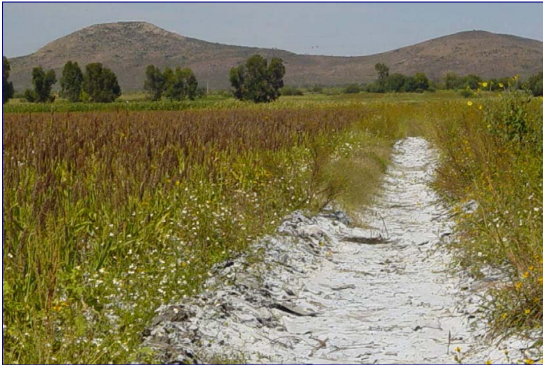
Figura E.16 Canal de conducción en tierra, con residuos de celulosa.
